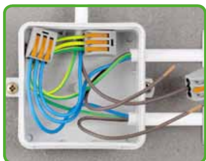
Oprzewodowanie puszki instalacyjnej przy użyciu przewodów linkowych
