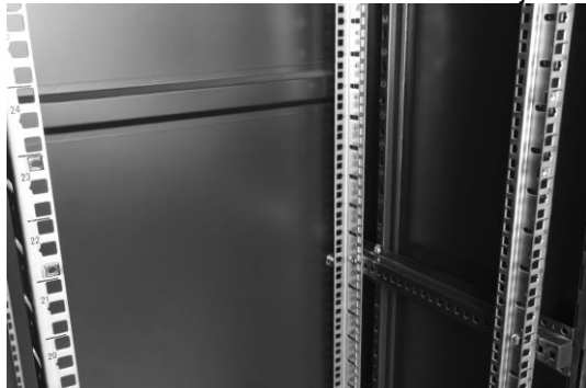
- zamontować koszyki pod śruby M6
